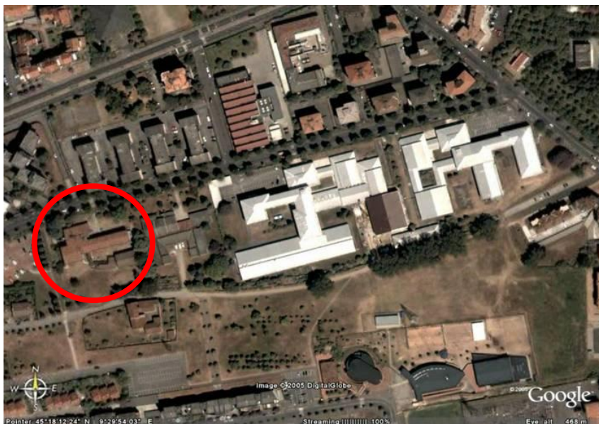
Fotografia aerea dell'area
