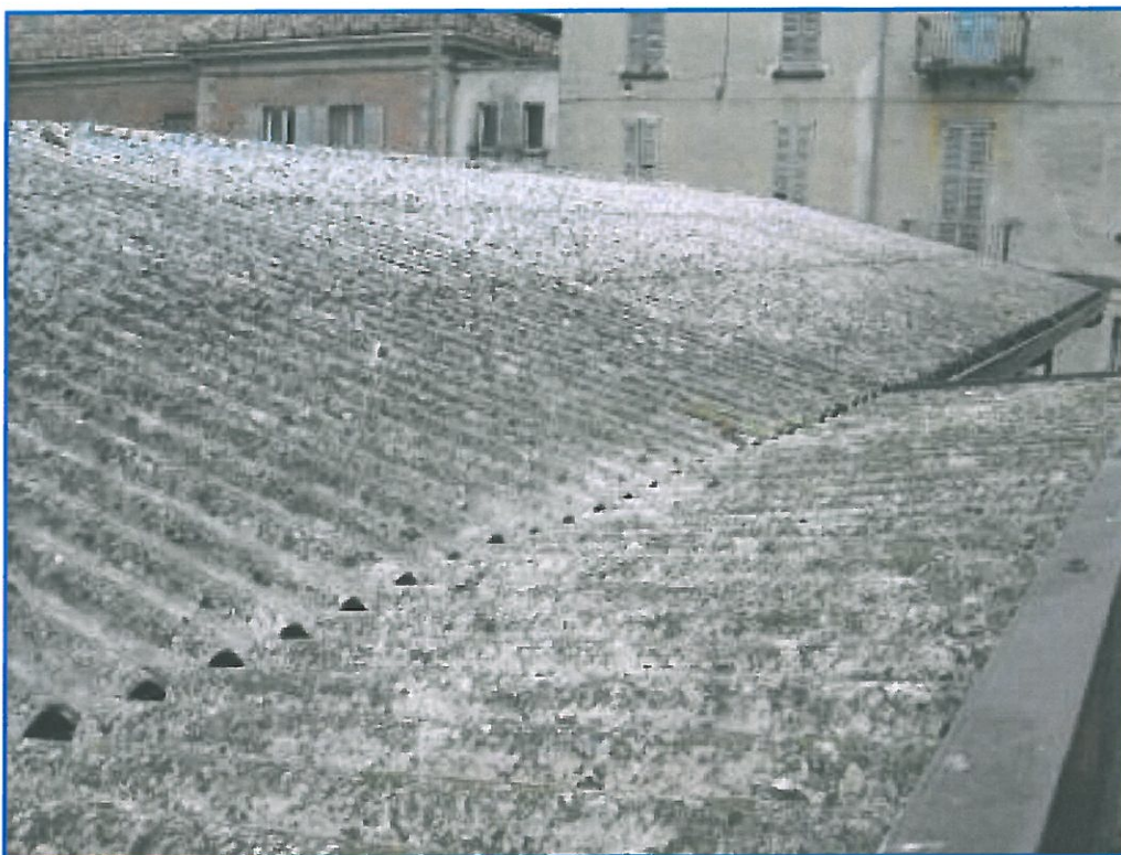
Foto 1 - Copertura in cemento-amianto presente sulla scuola materna "Il Giardino" di Lodi (LO)
