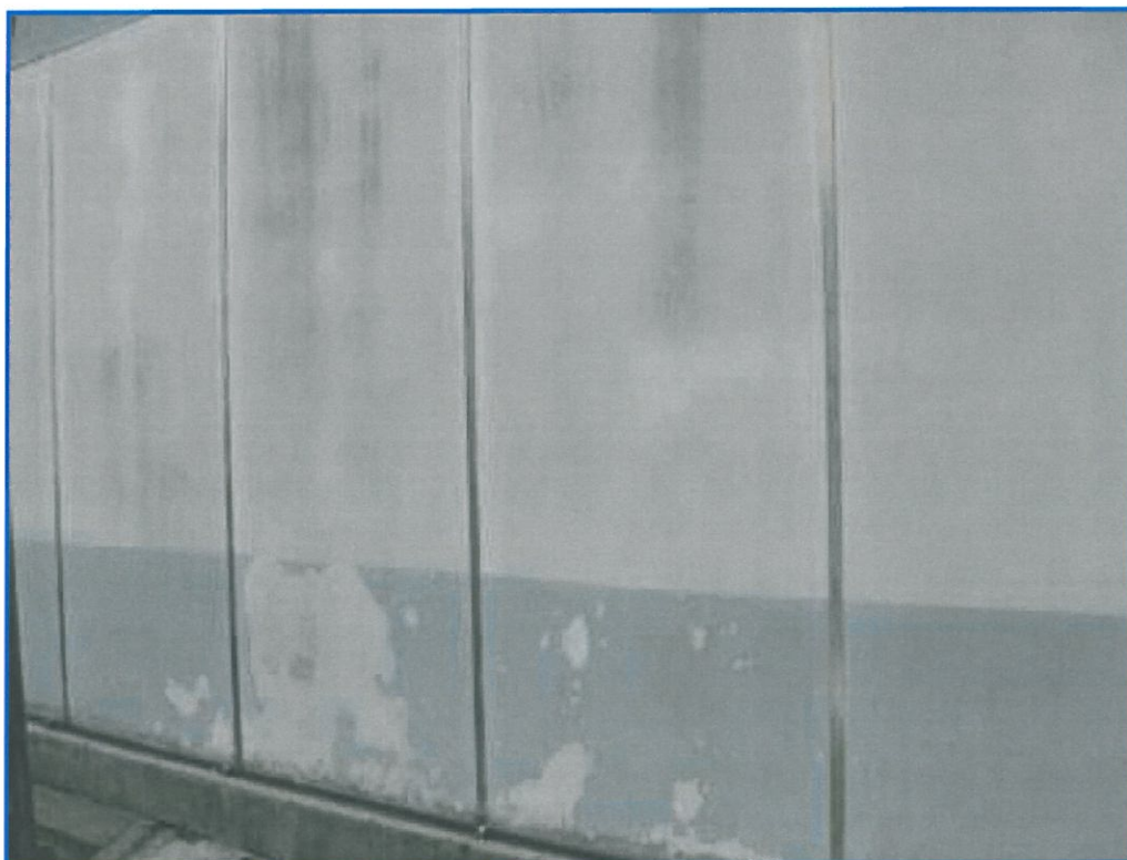
Foto 4 - Pannellature esterne in cemento-amianto
