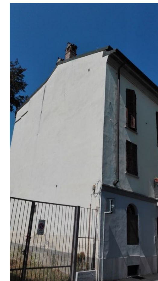
edificio confinante in via Legnano
