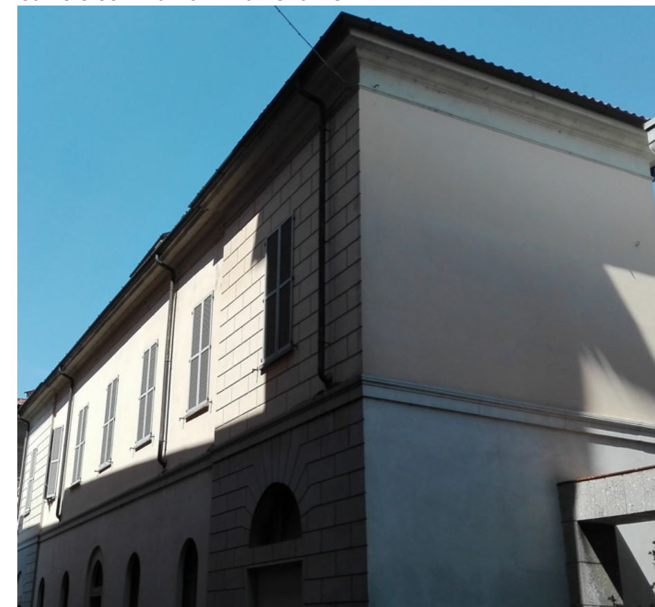
edificio confinante in via Volturmo
