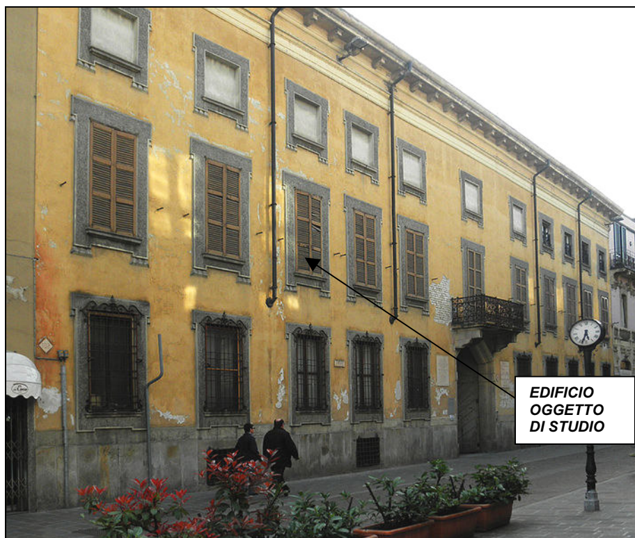
foto 1: vista dell'edificio oggetto di studio.
