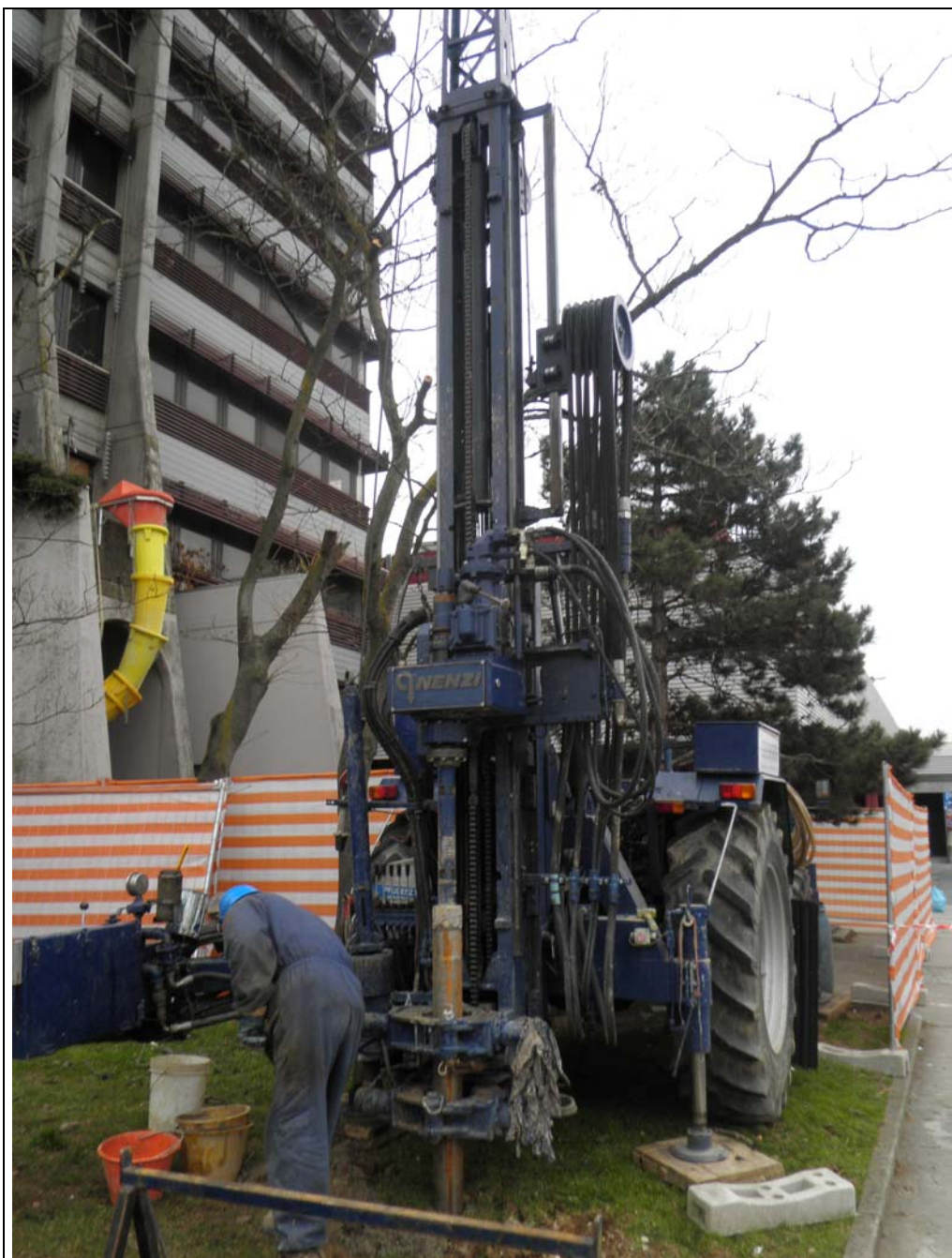
Foto 2 – Torre Uffici di Lodi: Sondaggio S1.
