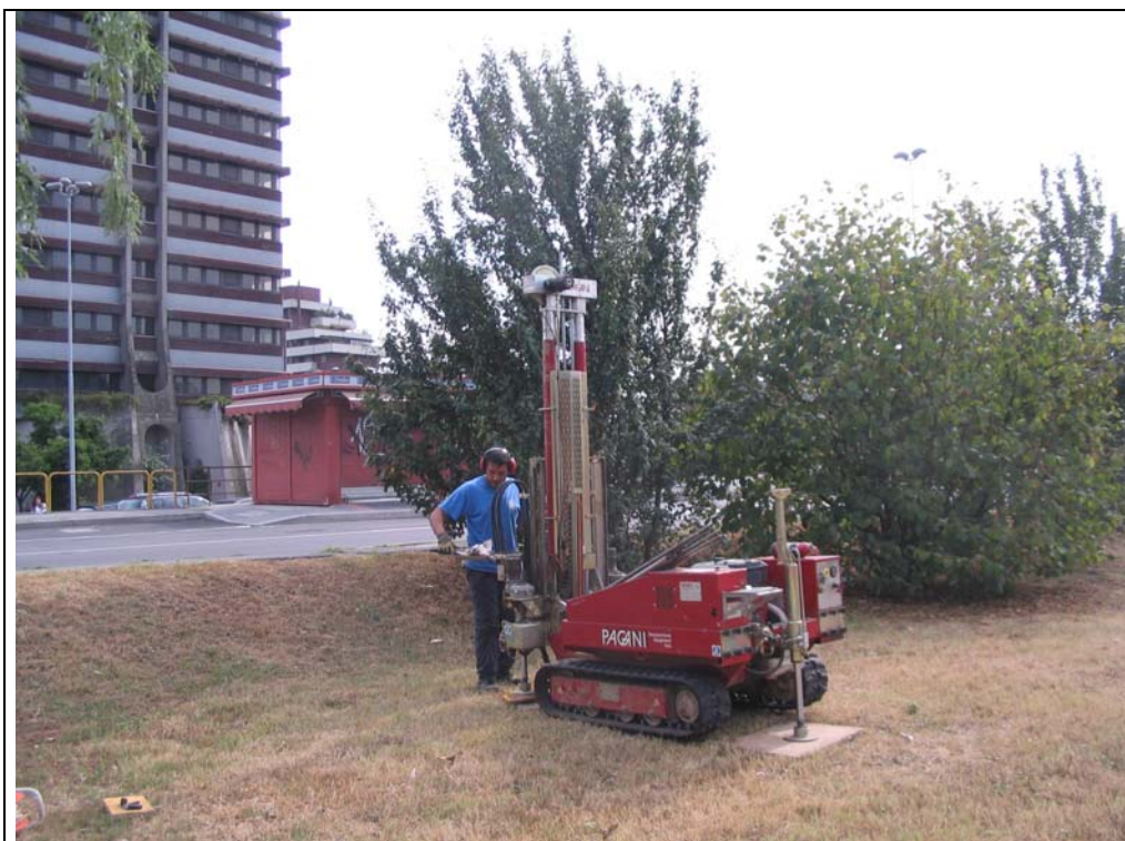
Foto 9 – Prova penetrometrica dinamica P3.
