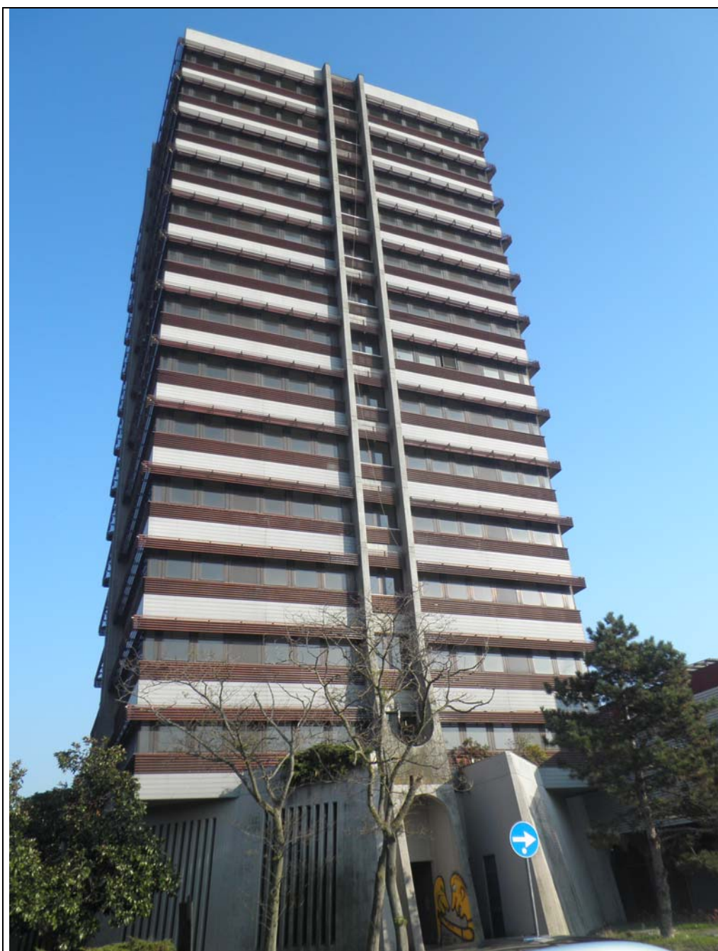
Foto 1 – Torre Uffici di Lodi: lato ovest.
