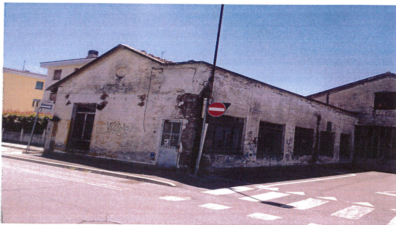
Vista da Via Calipari
