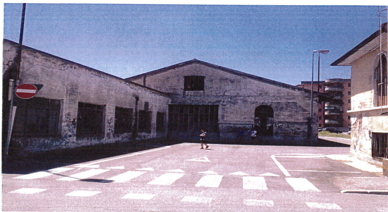
Vista da Via Calipari
