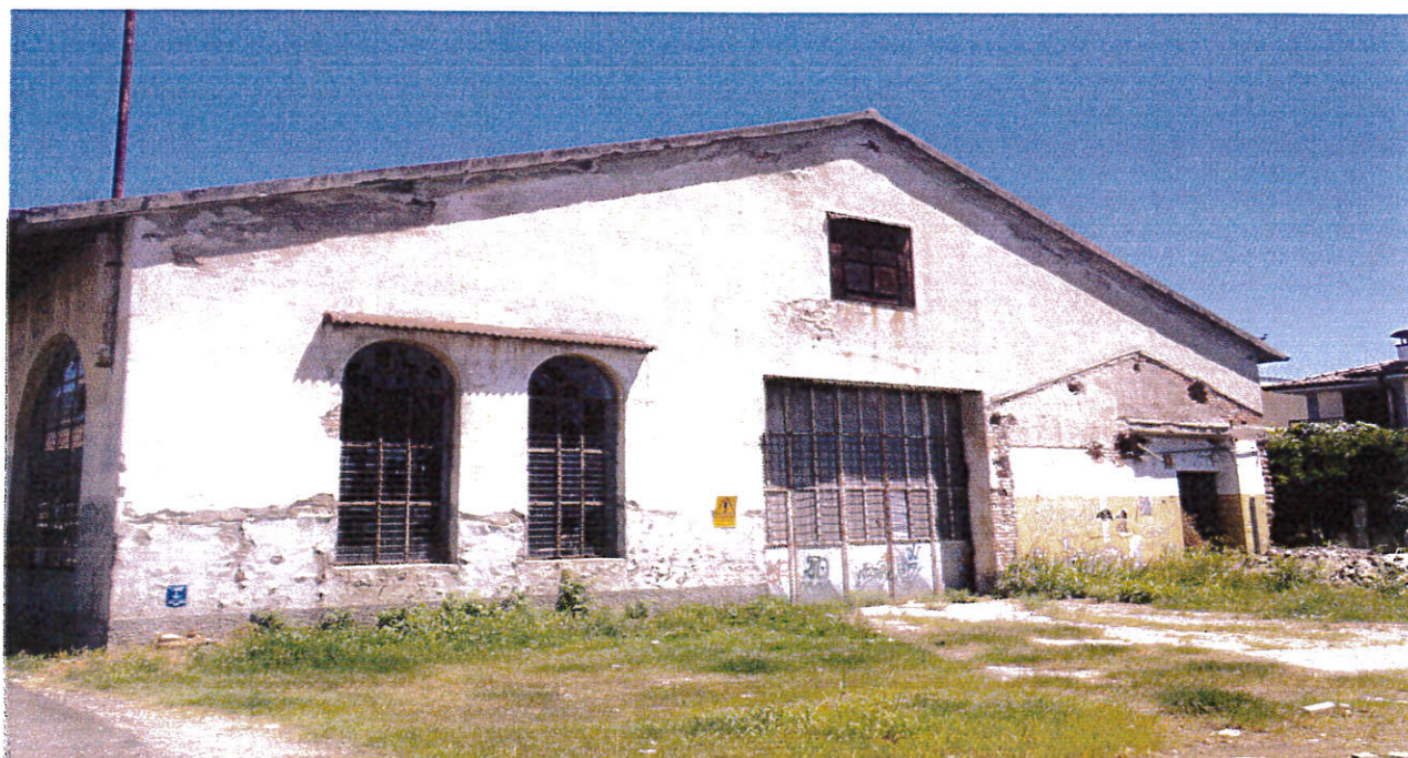
Lato retrostante Via Calipari
