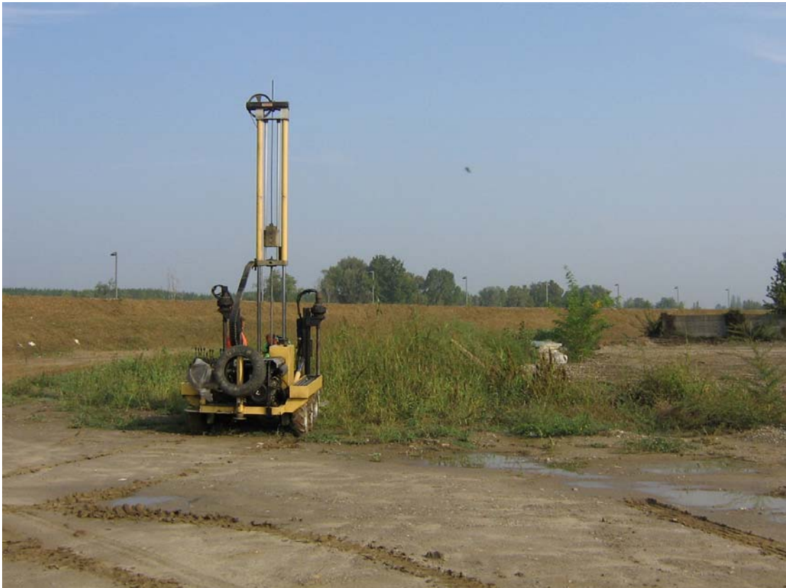
Foto 1. Esecuzione prove penetrometriche dinamiche
