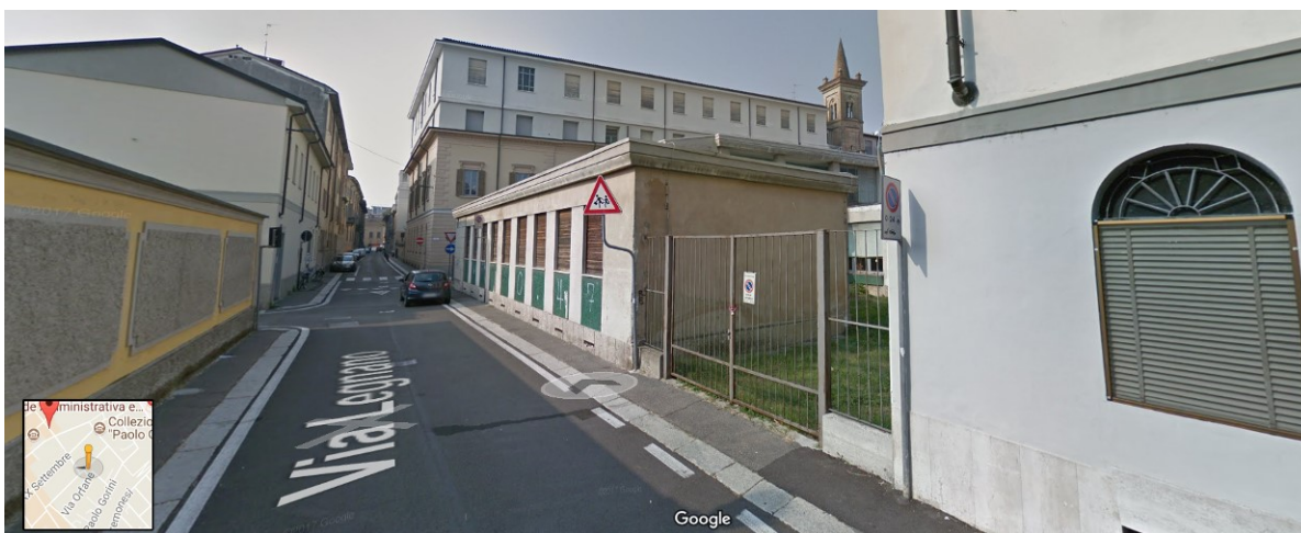
vista da via Legnano sull'area di PII, sulla destra, con l'attuale accesso carrabile.
