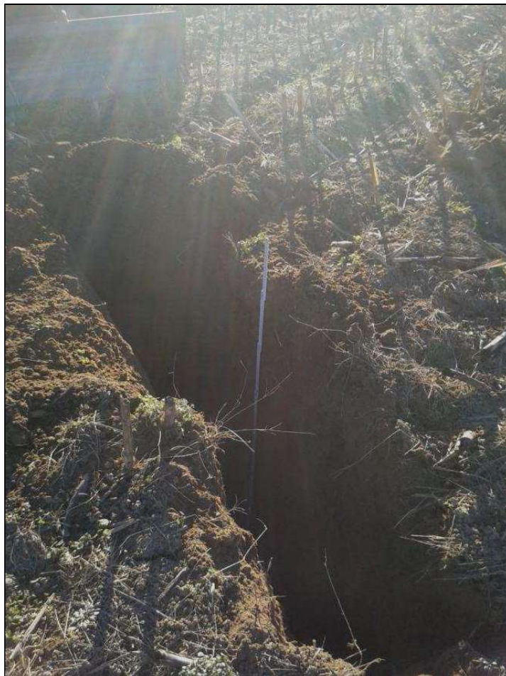
Foto 1 - Pozzetto esplorativo TA
