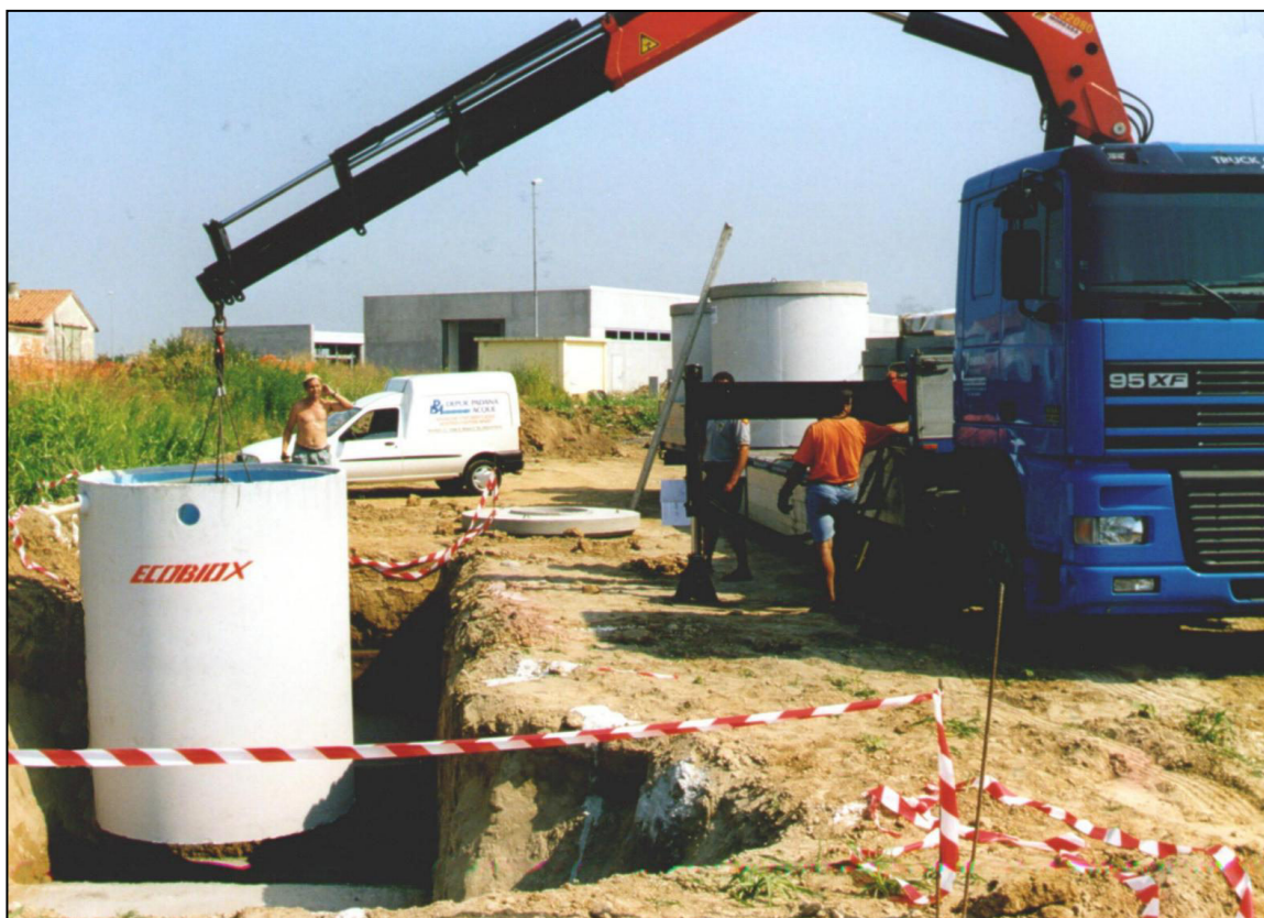
Fig. 3 – Fasi di interrimento impianto Mod. ECOBIOX ® 1 – Serie C
