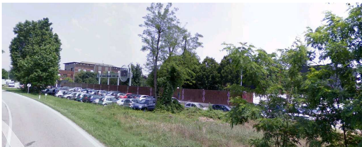
3. Vista delle strutture esistenti dalla SP 25 in avvicinamento all'entrata al complesso ICR. E' presente un parcheggio sul davanti.
