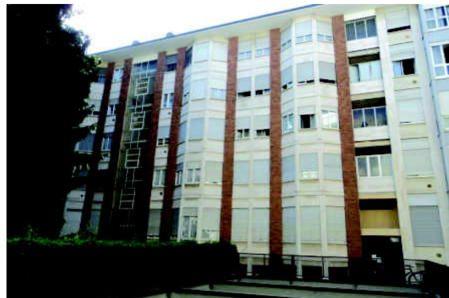
Foto 2 - Prospetto, fronte su corte interna
