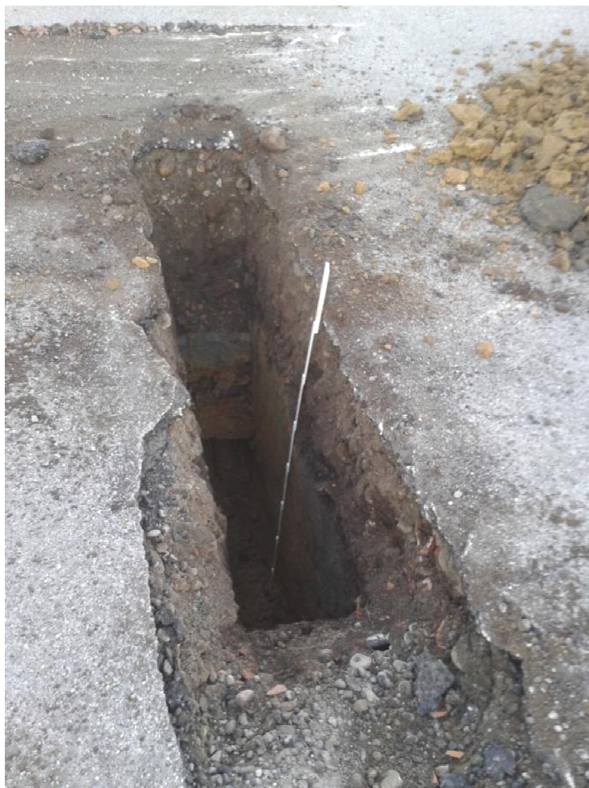
Foto 3: Pozzetto esplorativo TC
