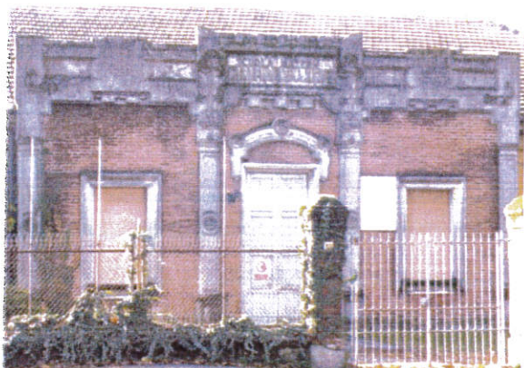
portale ingresso asilo
