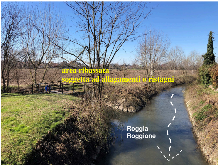
4A – Zona ribassata in località Bersaglio all'immissione di Roggia Gissara in Roggia Roggione con recapito finale nel fiume Adda.
