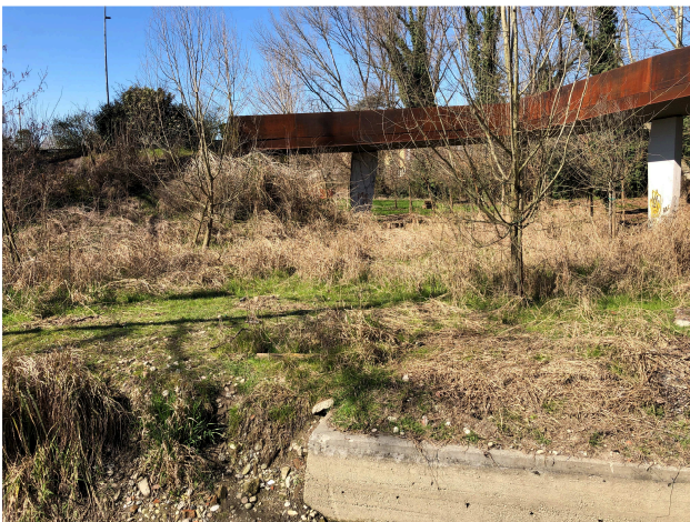
4E – Area ad ovest della roggia precedentemente descritta utile per laminazione “leggera” in caso di allagamenti e rigurgiti locali della roggia. E’ evidente lo stato di incuria dell’area che dovrà essere ripulita dei rifiuti e della vegetazione eccedente.
