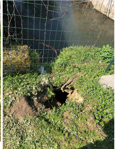
4F – Intubamento Roggia Gissara e locale cedimento spondale in corrispondenza di Viale Milano.
