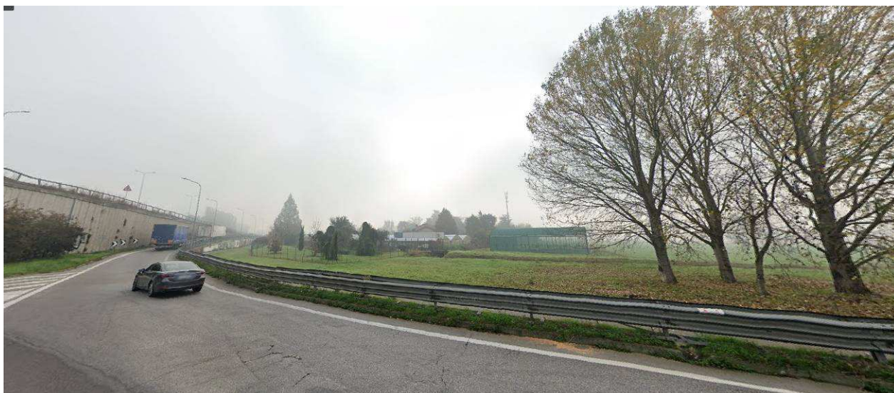
Vista sull'area in avvicinamento allo svincolo
