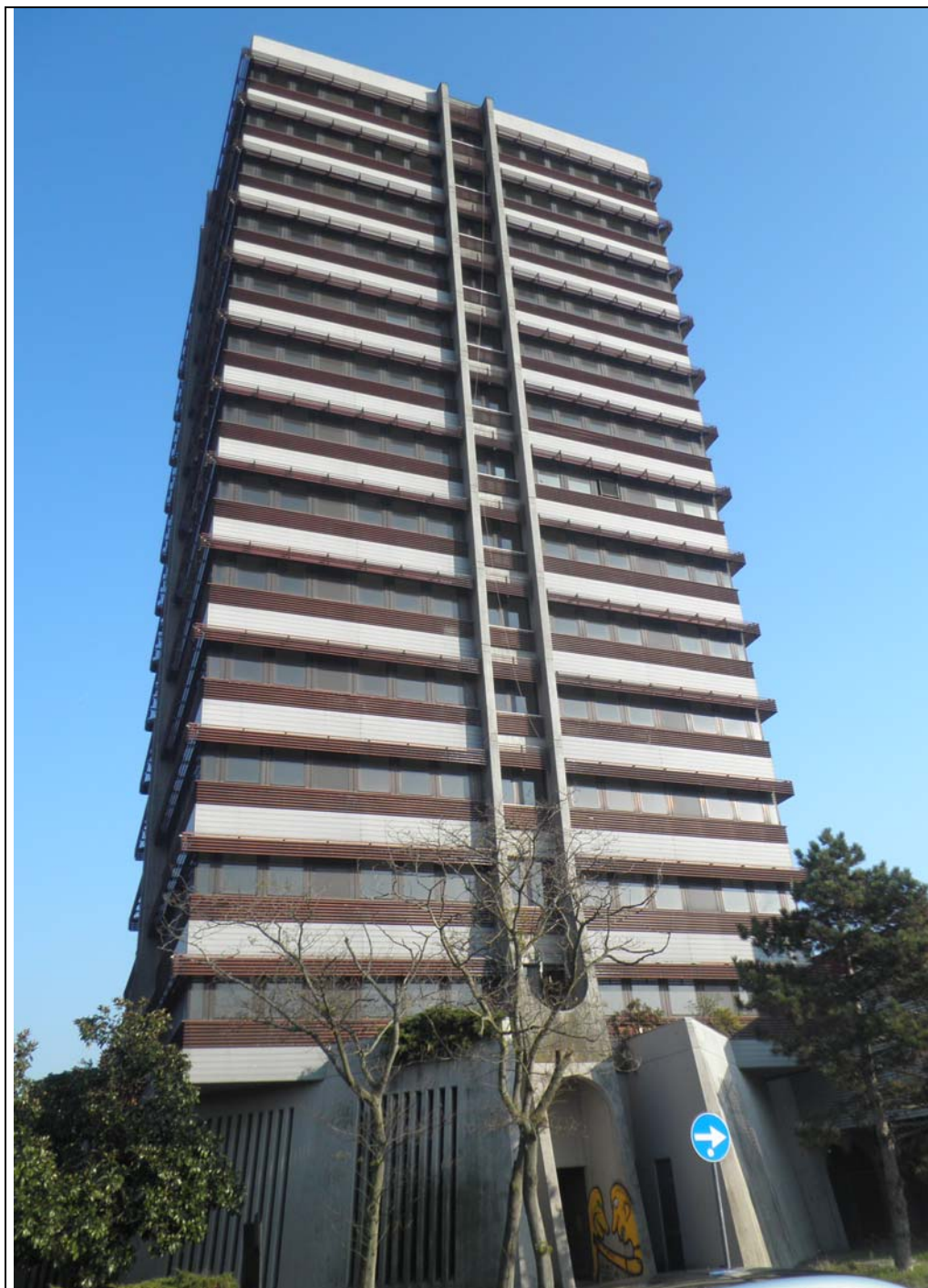
Figura 9 – Torre Uffici: stato di fatto – lato ovest
