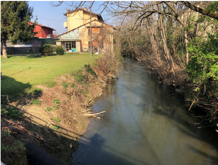
6G – Roggia Bertonica in frazione Olmo, sponda idrografica sinistra (a destra nell'immagine) cedevole con abbondante vegetazione arbustiva.
