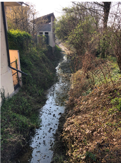
6G – Roggia Bertonica in frazione Olmo, sponda idrografica sinistra (a destra nell'immagine) cedevole con abbondante vegetazione arbustiva.
