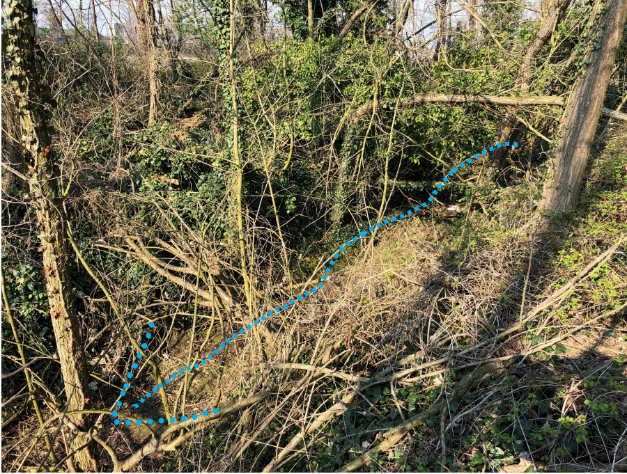
61 –Roggia Turana a frazione Olmo. L'alveo è invaso da sedimenti, arbusti e piante crollate.
