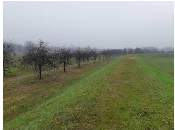
Foto 12 - Argine margine sud
